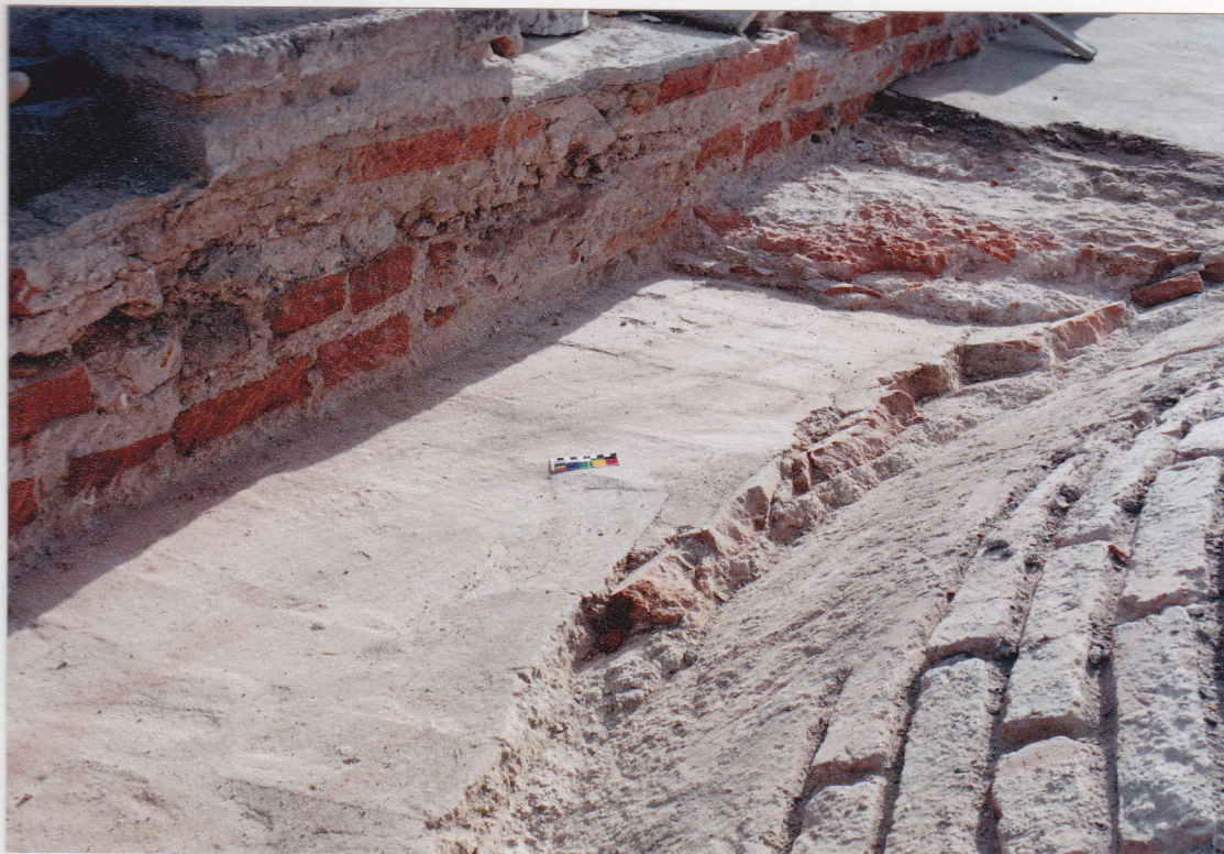
FOTOGRAFIA 01. PISO ORIGINAL DE NIVEL INFERIOR
